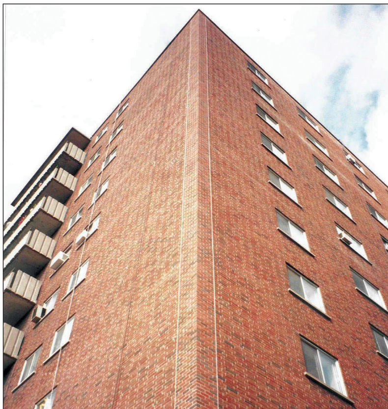
Photo 3 — Nouveau placage et joint vertical
