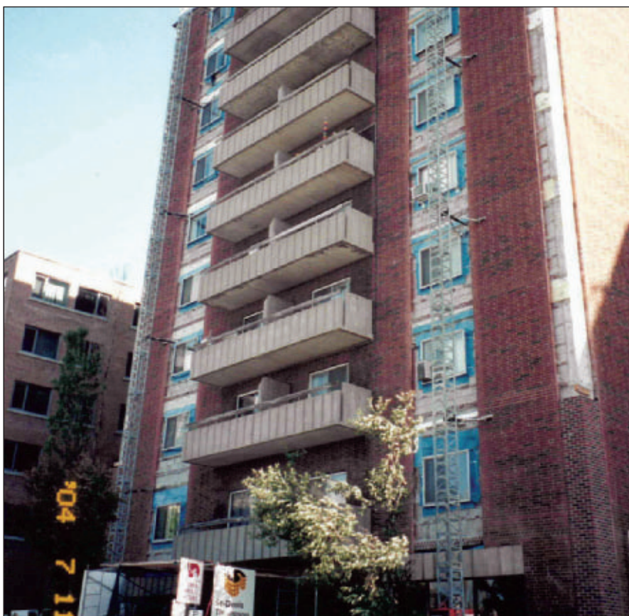
Photo 1 — Enlèvement du placage aux angles et au pourtour des fenêtres
